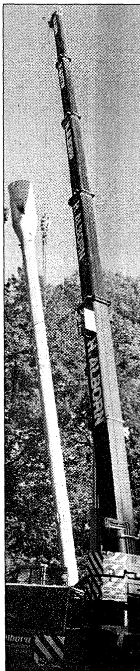
Der 20 m lange Stahlmast der Sirene gleitet sanft zu Boden. Foto: Georg Hesse
