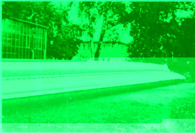
30 Meter lang ist der Hochwasserschutzschlauch aus hochfestem Polyestergerewebe. Er kann einzeln, aber auch in Kombination mit weiteren Schläuchen als Wassersperre benutzt werden.
