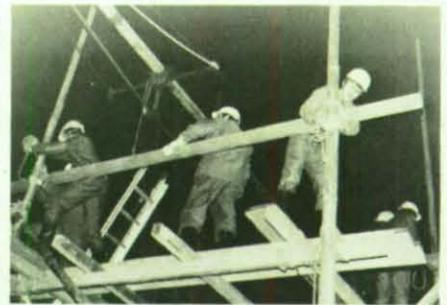
Mit Hilfe eines 6 m hohen Arbeitsgerüsts konnte ein Absperrschieber eingebaut werden.
