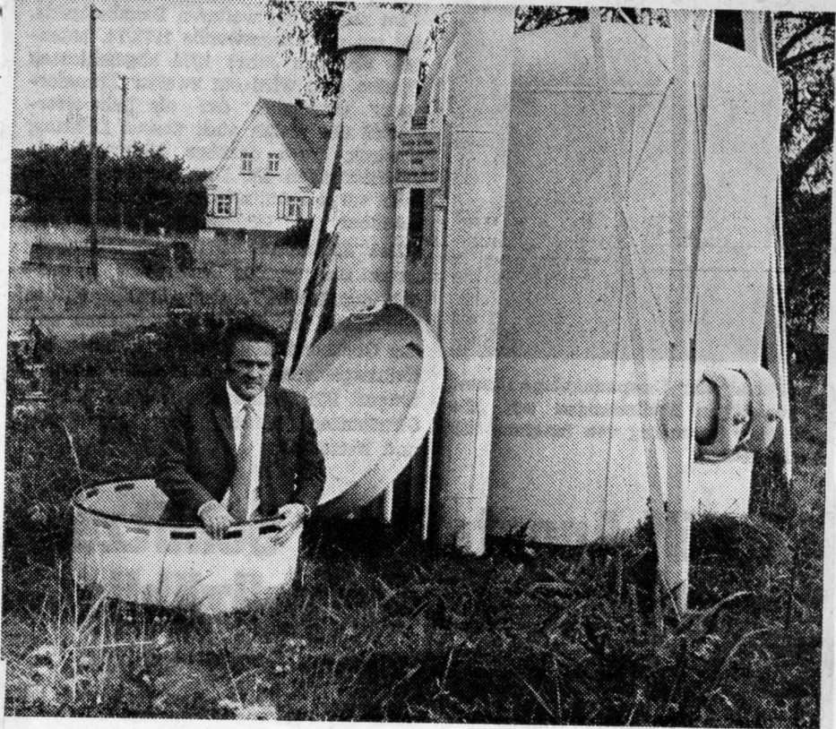
Kreisamtmann Schäfer, Sachbearbeiter des Katastrophenschutzes im Landratsamt, inspiziert die Preßluftsiirene in Reuffelbach. Durch die Einstiegluke gelangt man in einen unterirdischen Stahlbehälter, in dem Stromaggregate, Batterien und Pumpen installiert sind. Der große Behälter zwischen dem Gestänge ist ständig mit Preßluft gefüllt. Sinkt der Druck unter eine vorgeschriebene Marke, so setzt sich automatisch eine Pumpe in Betrieb.
