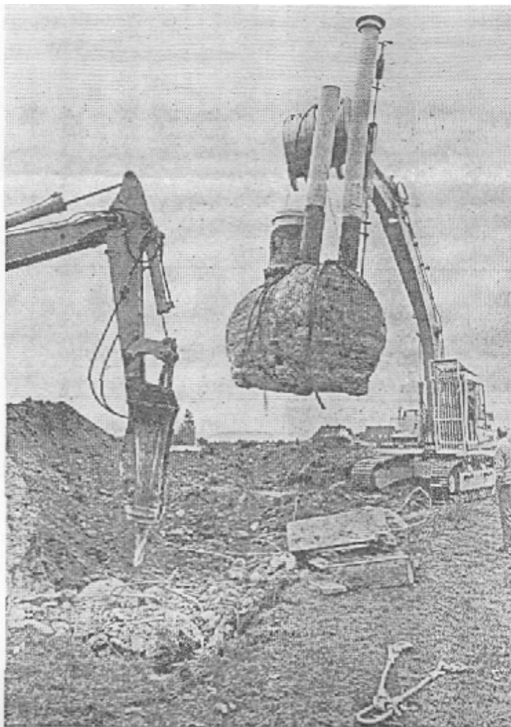
Der Stahlmast der Hochleistungssirene wurde mitsamt den Tanks für Kompressoranlage und Druckluftvorrat demontiert. Foto: Ruppert
